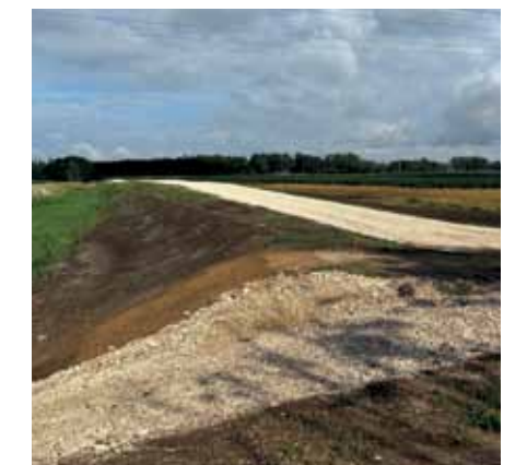
Der neu errichtete Deich entlang des Flutkanals in Thierhaupten verbessert künftig den Hochwasserschutz.
