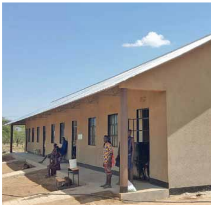
Die Fertigstellung der ersten Phase des Schulaufbaus
